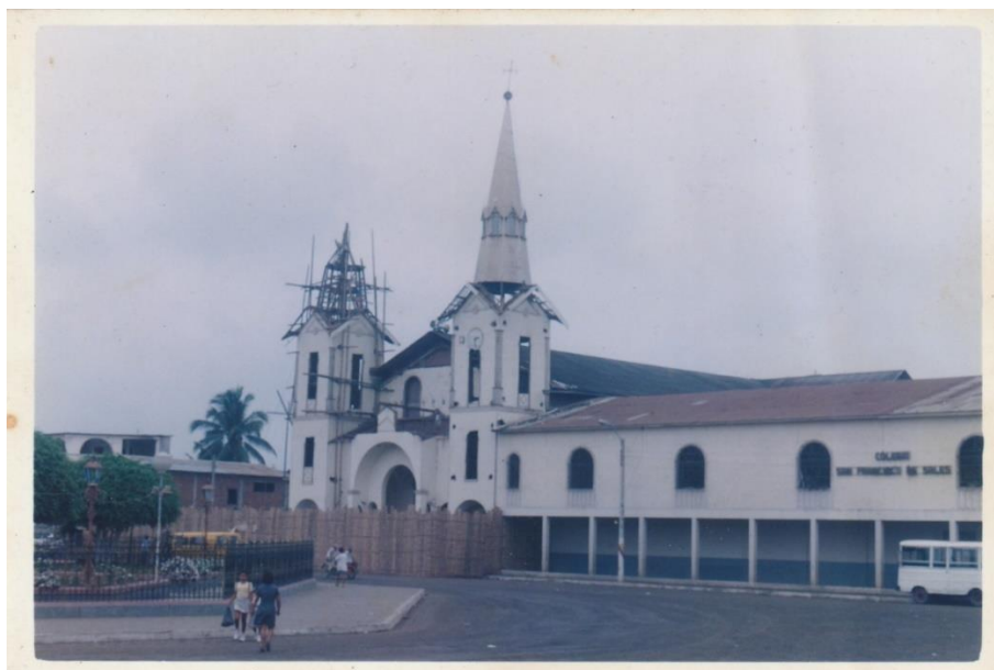
Foto 58 Reconstrucción de la iglesia
