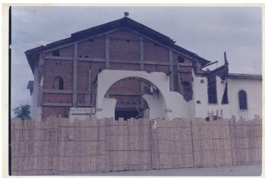
Foto 59: La parte delantera de la iglesia en la reconstrucción.
