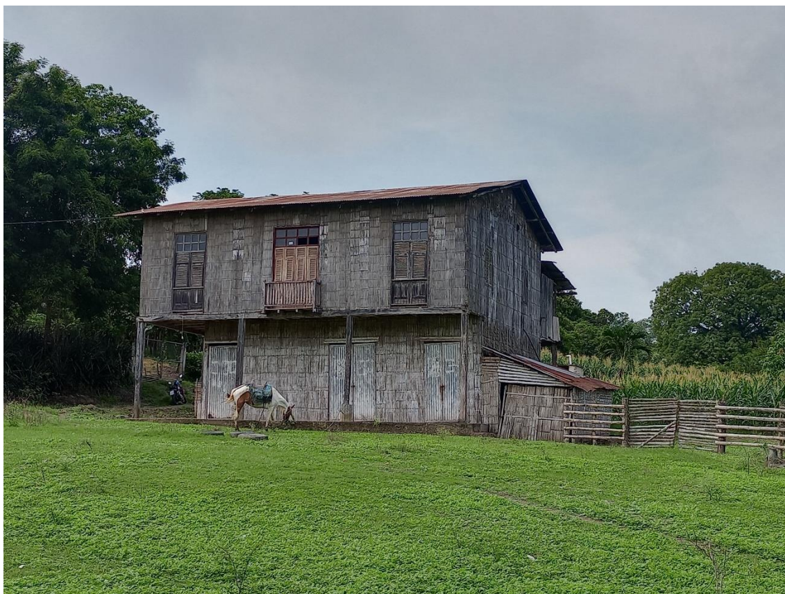
Foto 21 Casa de construcción antigua del sitio Danzarín
